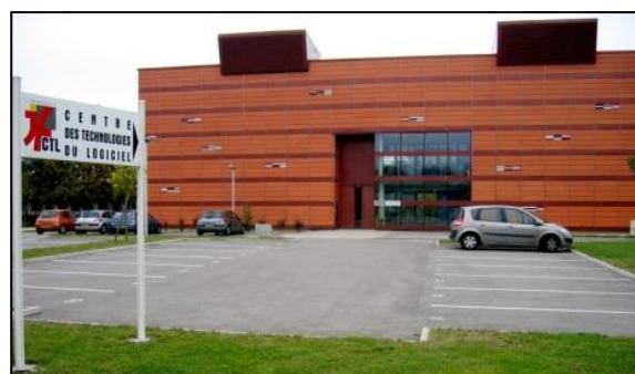
Le bâtiment du CTL
